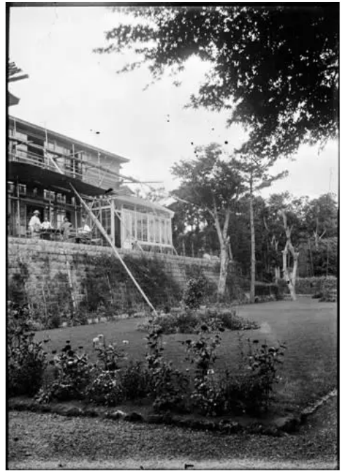
建築中の東京・富士見町(当時)のグラバー私邸を撮影した写真(グラバー園提供)
